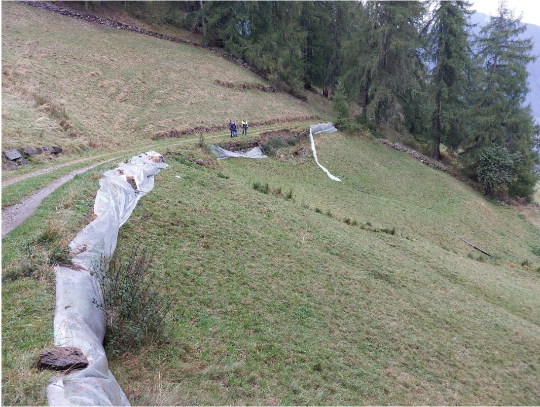
Vista da monte della sede stradale in fase di cedimento
