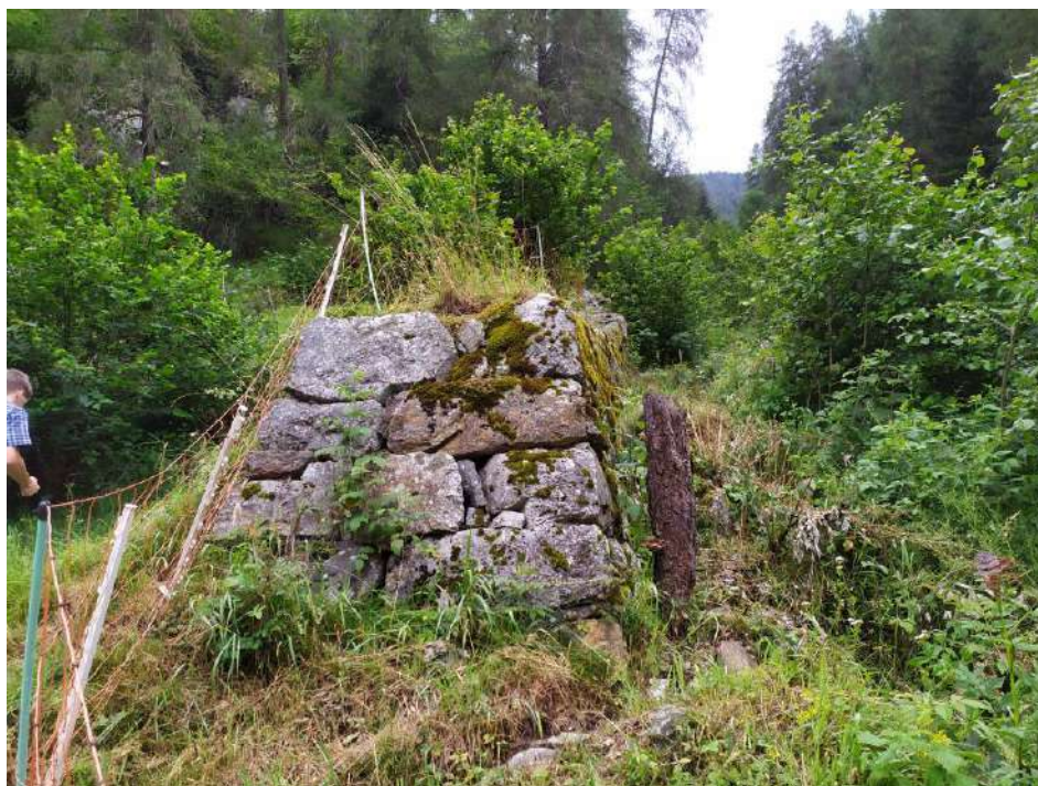
Foto 5.7 - Panoramica da valle del muro di contenimento realizzato all'apice della conoide negli anni '50 a difesa della frazione Zanon.
