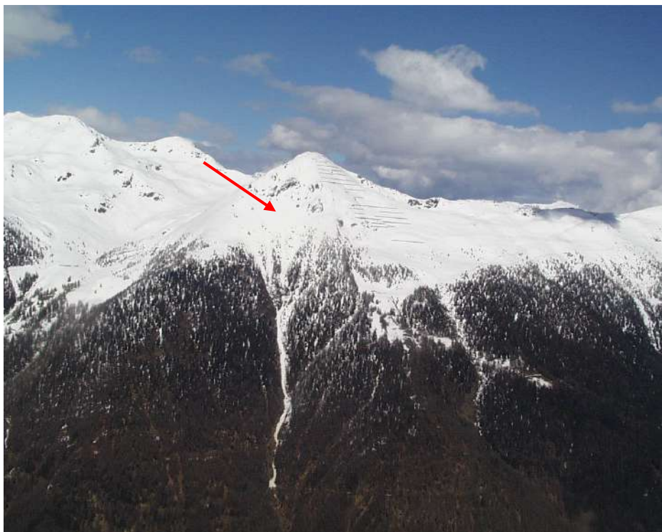
Foto 5.3 - Panoramica aerea della porzione medio – alta del sito valanghivo in esame con evidenziata dalla freccia rossa la zona di potenziale distacco prima della realizzazione delle opere di mitigazione del pericolo.
