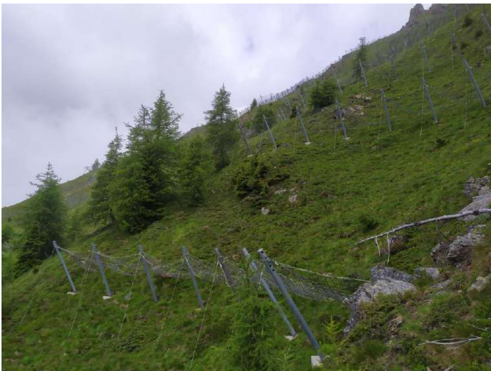
Foto 5.5 - Panoramica delle opere di mitigazione del pericolo realizzate nella zona di potenziale distacco della valanga della Val Nigolaia.
