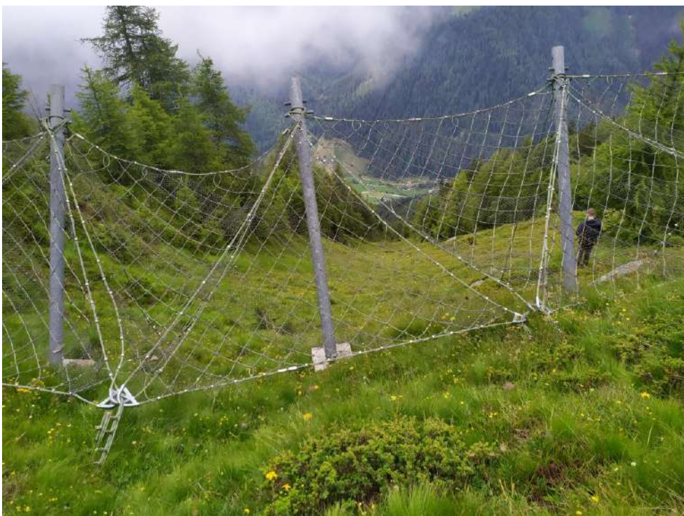
Foto 5.6 - Panoramica da monte delle opere di mitigazione del pericolo realizzate nella zona di potenziale distacco della valanga della Val Nigolaia.
