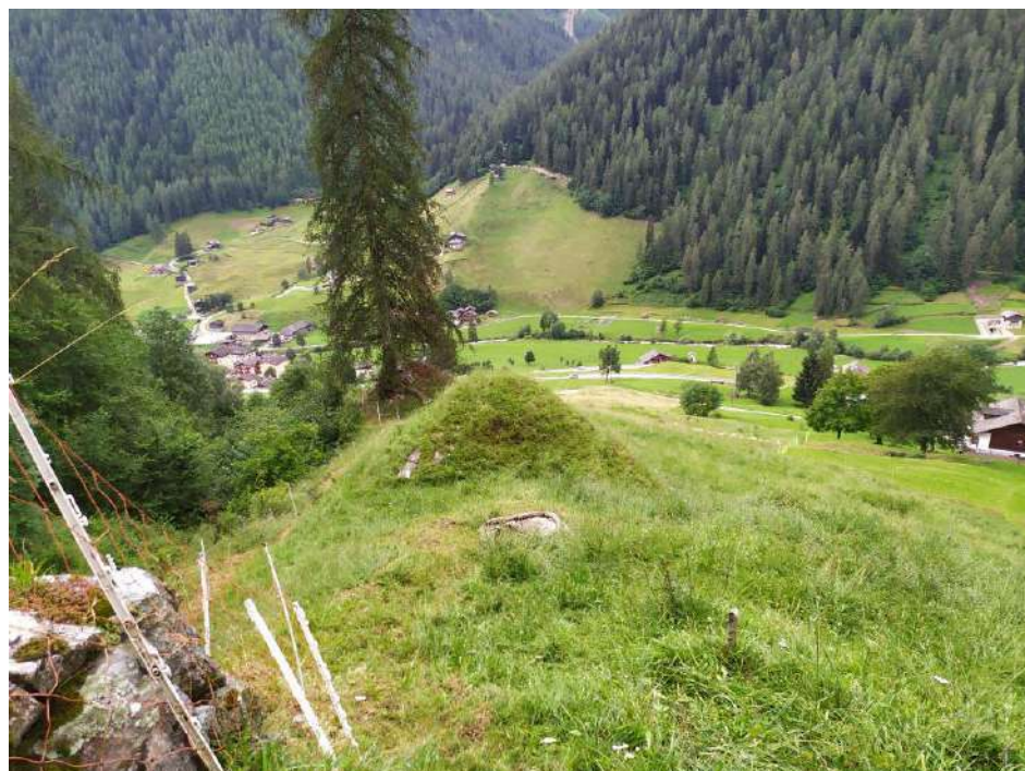
Foto 5.8 - Panoramica da monte di uno dei cumuli di materiale realizzati all'apice della conoide negli anni '50 a difesa della zona edificata.
